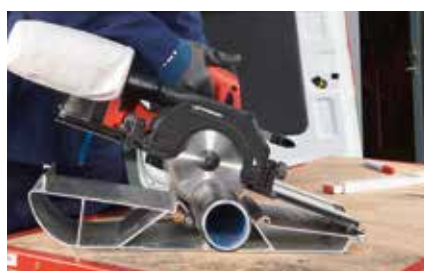
Corte de tubos
